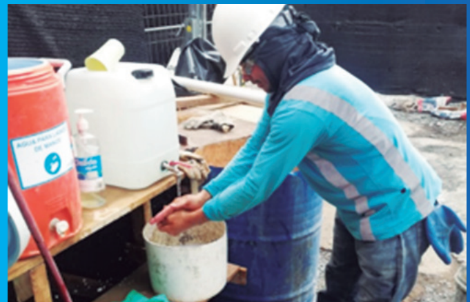
Verificación de aseo personal como lavado de manos en planteles de los contratistas.
